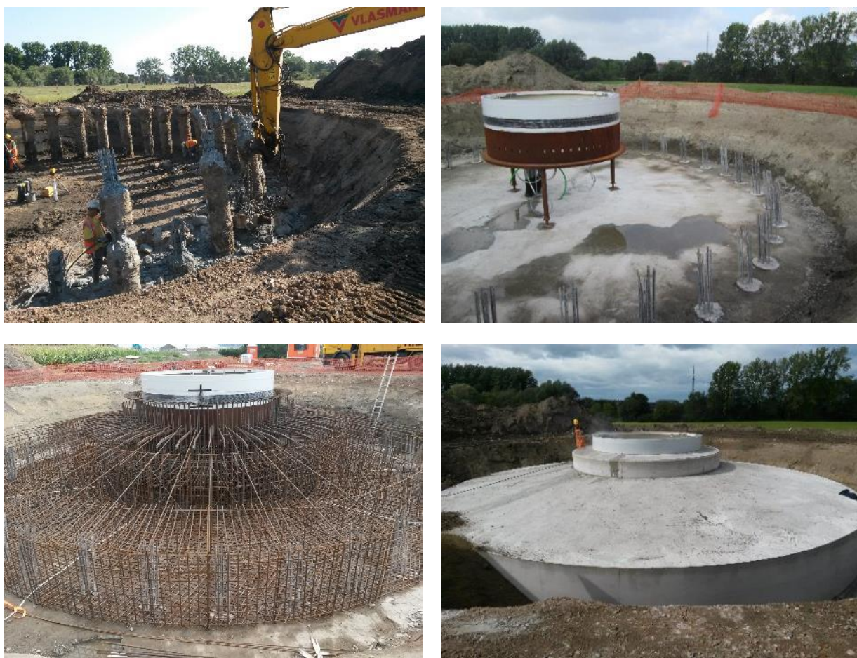
Figure III.4-9 : Mise en place de la fondation d'une éolienne (source : Eoly)
