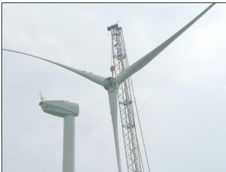
Figure III.4-11 : Montage du rotor d'une éolienne (source : The Wind Power)
