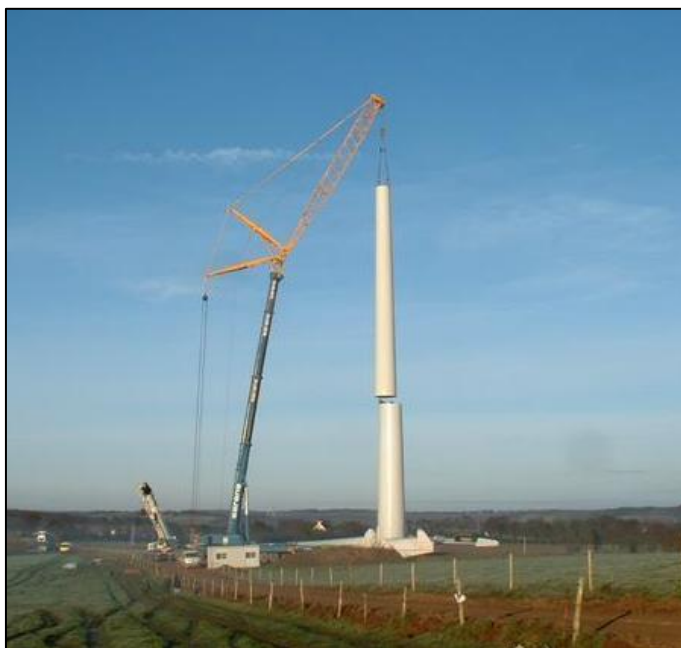
Figure III.4-10 : Érection du mât d'une éolienne (Source : Eric Burlot, (parc éolien du Haut Corlay, France)).
