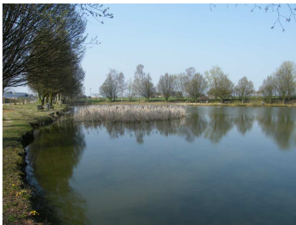
Figure 61 - Bassin d'orage de Crehen
