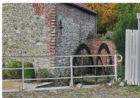
suite, il a été rehaussé à l'aide de briques. L'ancien moulin a été conservé dans l'état où il se trouvait en 1999. Le mécanisme du moulin est toujours présent à l'intérieur du bâtiment. La roue à augets située à l'extérieur est fortement dégradée et rouillée, et il ne coule plus d'eau dans le bief.
