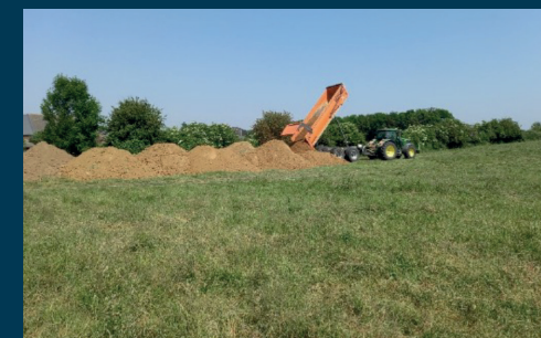
Travaux en cours - ZIT rue Loriers ©Ville de Hannut
