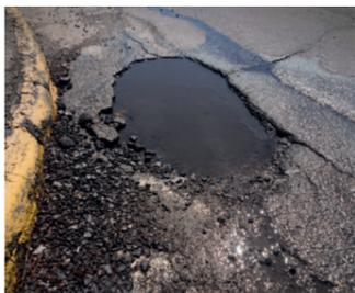
Réparer un nid de poule est un processus qui nécessite de l'attention, des compétences et des conditions spécifiques. Il est, par exemple, essentiel de choisir dans la mesure du possible une journée où il ne pleut pas, car l'eau peut entraver le processus de réparation et affecter la qualité du travail. Il en va de même avec les périodes de gel.
